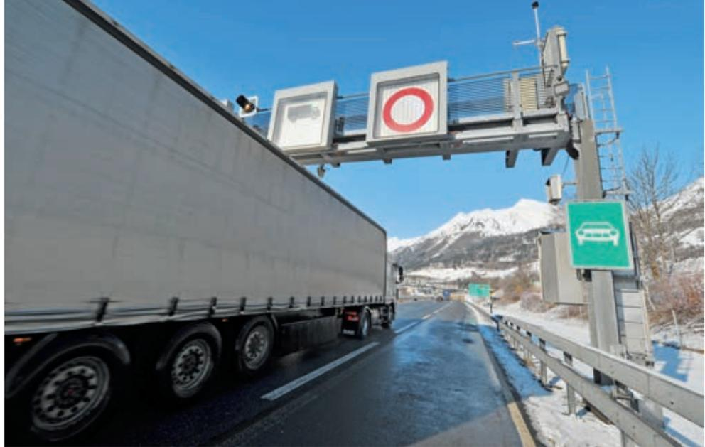
Das Thermoportal bei Airolo «durchleuchtet» die vorbeifahrenden Lastwagen.
